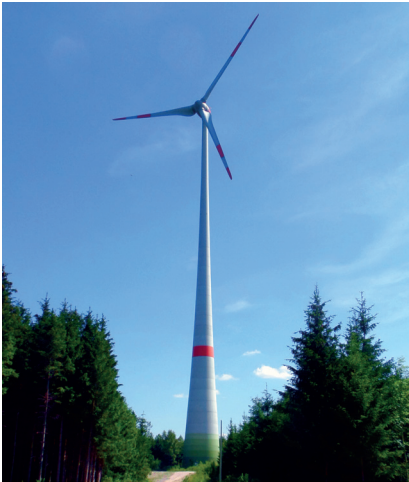
Bild 4.38 Fertigteil-Betonturm (Enercon E-82, Bemessungsleistung 2,3 MW, Nabenhöhe 138 m, Inbetriebnahme 2012) am Windstützpunkt Wildpoldsried (Bayern)
