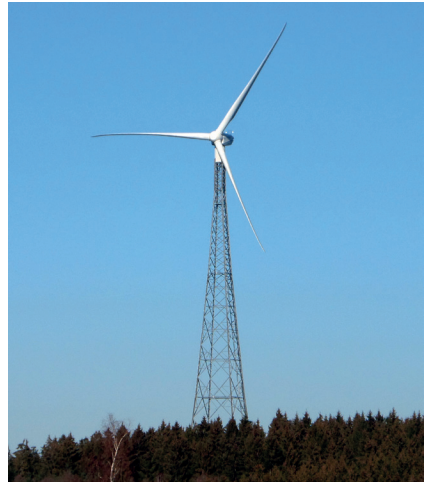
Bild 4.39 Gittermastturm (Südwind S-77, Bemessungsleistung 1,5 MW, Nabenhöhe 112 m, Inbetriebnahme 2002)
