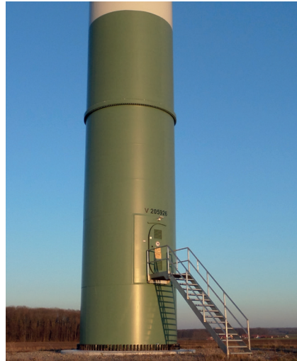
Bild 4.37 Stahlrohrturm (Vestas V112-3.0 MW)
