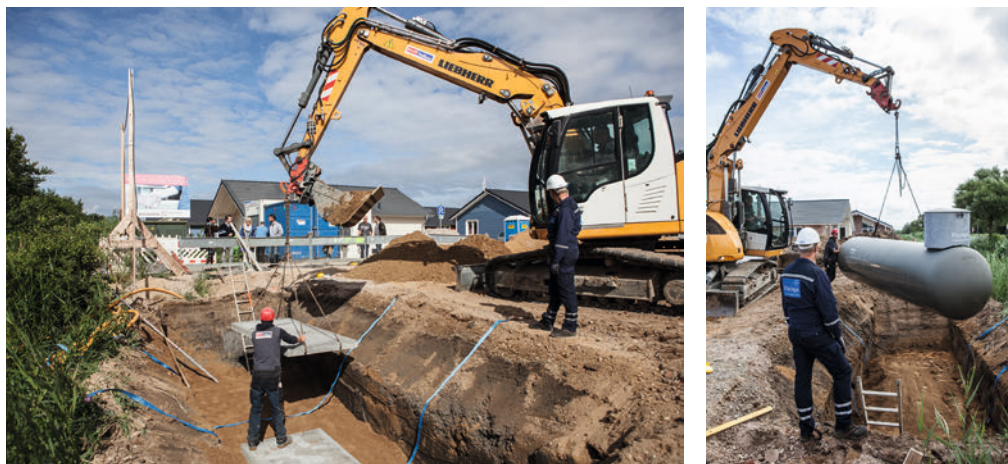
Bild 5.2 Einlagerung eines Flüssiggastanks in der Ferienhaussiedlung Min Huus an de Küst in Dagebüll
