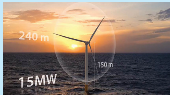
Bild 8.6 Windrad von morgen – die Referenzanlage des National Renewable Energy Laboratory, Quelle: NREL
