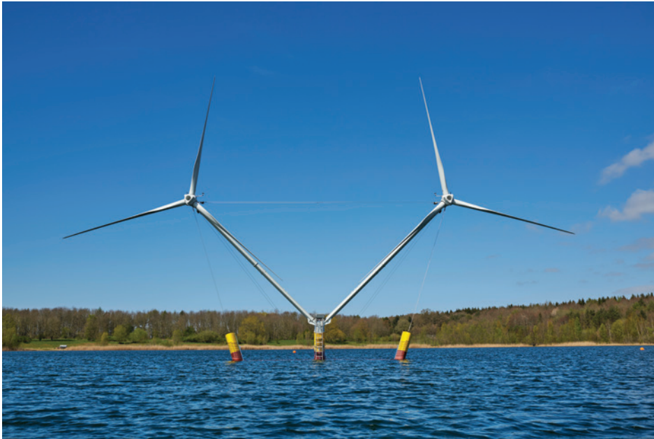
Bild 8.8 Diesen 18 Meter hohen Prototypen des Zwillingwindrades Nezzy testen die EnBW und das norddeutsche Ingenieurunternehmen „aerodyn engineering“ in einem Baggersee bei Bremerhaven. Quelle: EnBW/Fotograf Jan Oelker
