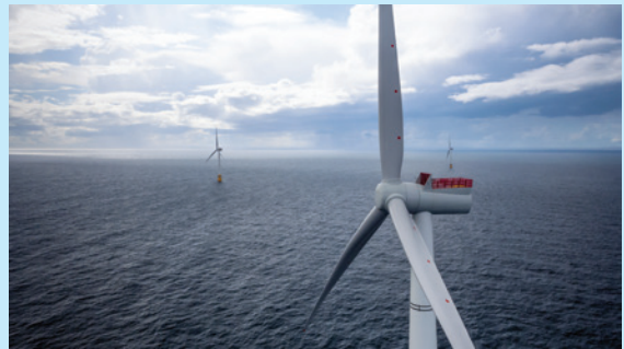
Bild 8.4 Hywind Scotland schwimmt! Fünf Windturbinen, jeweils sechs Megawatt stark, bilden den weltweit ersten Schwimmwindpark. Quelle: Equinor
