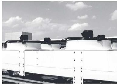
**Bild 1.1:** Rückkühlwerk einer Klimaanlage.
