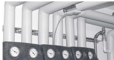
**Bild 1.7:** Gedämmte Rohrleitungen.
