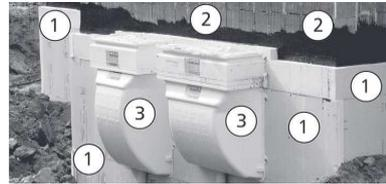
**Bild 1.6:** Beispiel für eine Wärmedämmung: Perimeterdämmung ① aus extrudiertem Polystyrol (XPS) an einer betonierten Kellerwand mit darüber liegender ungedämmter Ziegelwand ② sowie Aussparungen im Bereich der Lichtschächte ③. Oberhalb der Wärmedämmung ist eine Feuchtesperre in Form einer Bitumendickbeschichtung (schwarz) erkennbar, die ebenfalls keine „Isolierung“ darstellt.
