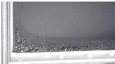
**Bild 1.8:** Tauwasser und mehrdimensionales Temperaturfeld an einer Verglasung.
